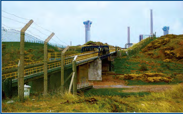
Рис. 2.3. Трубопровод для отвода ЖРО в море
