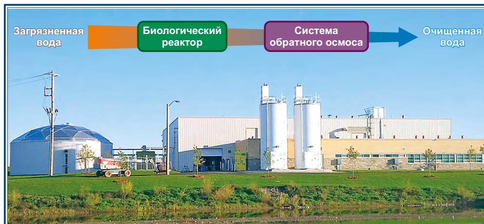
Рис. 4.21. Новая водоочистная установка в Порт Грэнби
