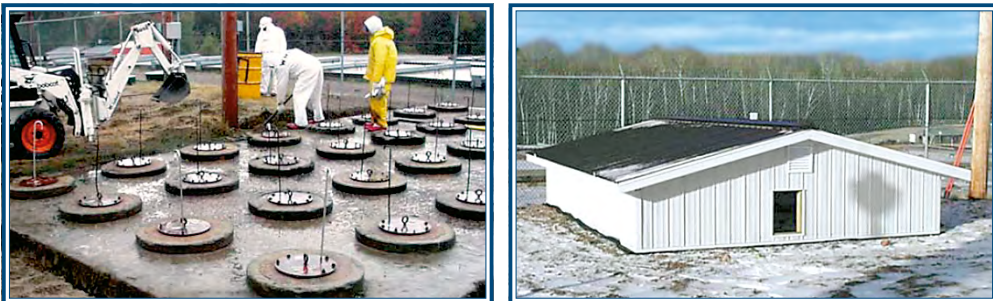
Рис.4.7. Проведение работ по модернизации дренажной системы и сезонные укрытия от атмосферных осадков площадки хранения ОЯТ
