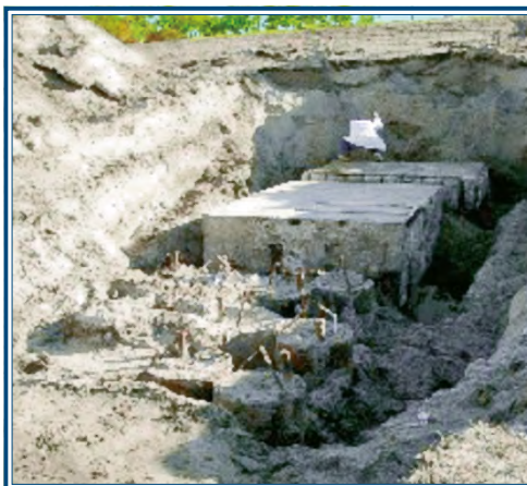
Рис.4.10. Извлечение бетонных бункеров с ЖРО
