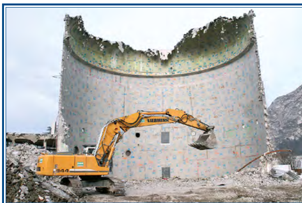
Рис. 3.27. Работы по сносу здания исследовательского реактора Siloé
