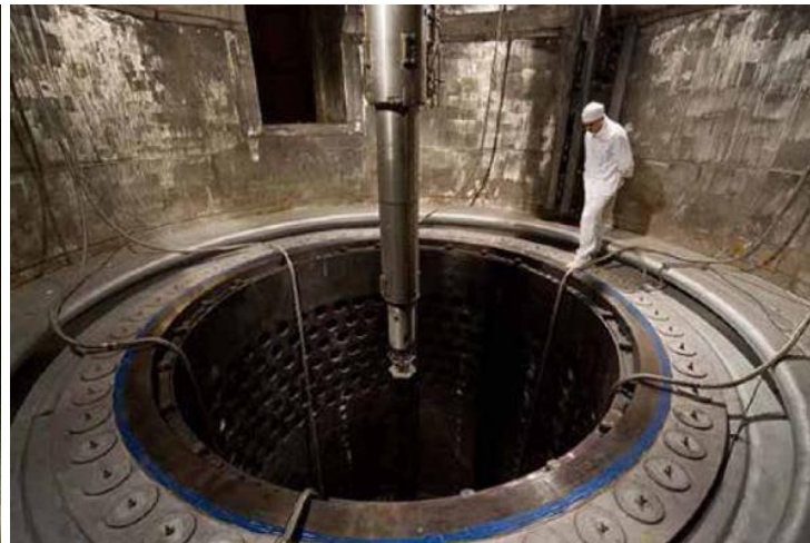
Загрузка ТВЭЛа в реактор на четвертом блоке Калининской АЭС. Фото: ОАО
