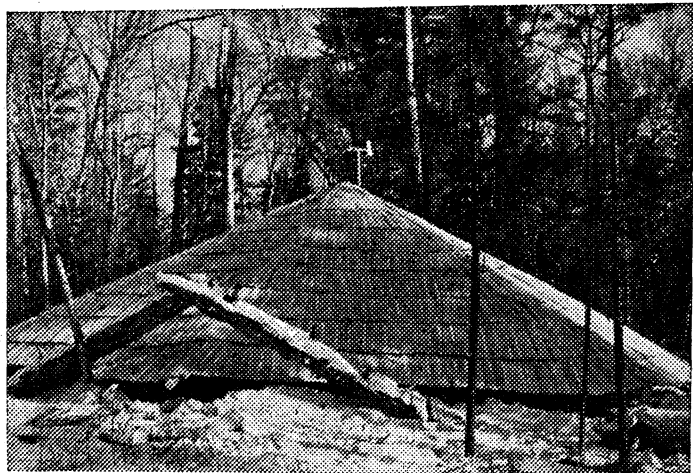
Рис. 30. Защитный шатер над кратером № 10 (40) диаметром 12,8 м.
